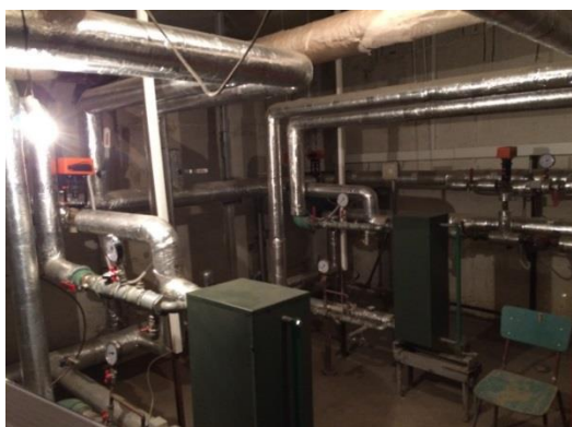
2.15.attēls: Siltummezgls, vecais čuguma radiators tika iestrādāts dekoratīvajā kārbā
