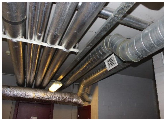
Ventilācija telpa zem tribīnes bez rekuperācijas
